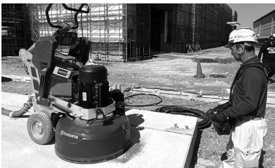
写真2 自走式研磨機による屋外作業
