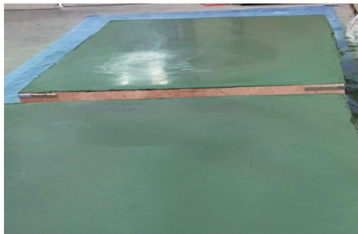
フェロコン仕上げ(写真上がプラスチック鏡仕上げ、写真下が金鏡仕上げ)
