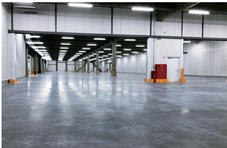
KL工法による床仕上がり
