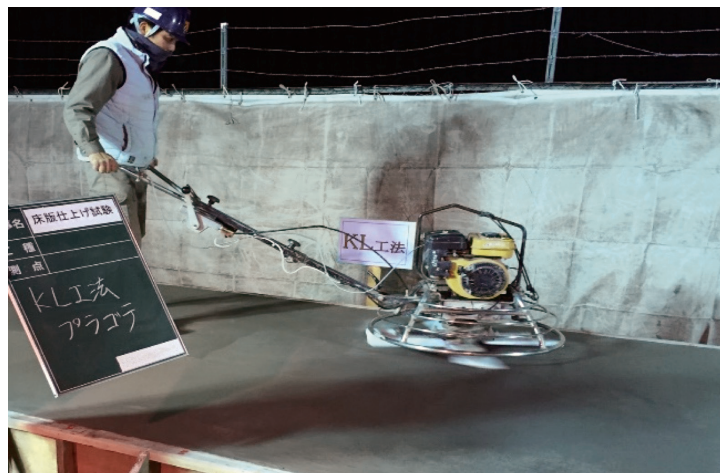
KL工法 床版仕上げ試験
